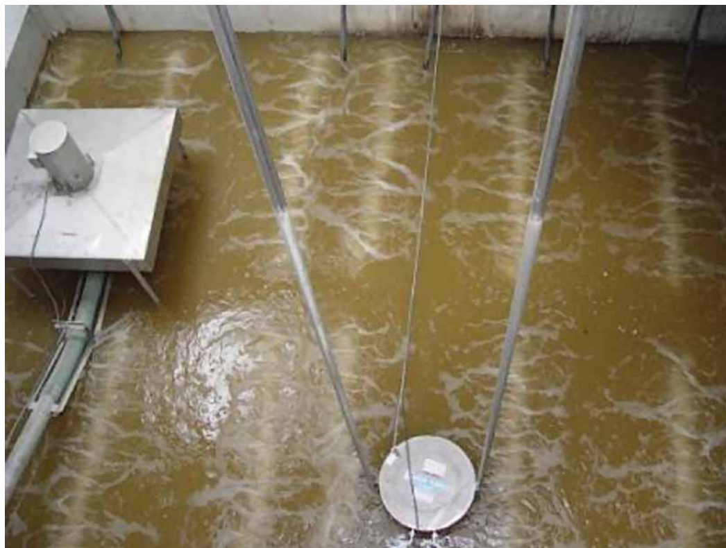
Рис. 2. Биореактор SBR – декантер, мешалка и система аэрации
