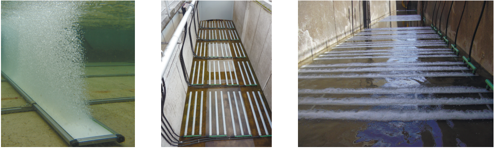
Рисунок 2. Установка пластинчатых диффузоров на городских очистных сооружениях
