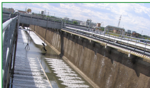
Пластинчатые аэраторы на Новолуберекской станции аэрации
