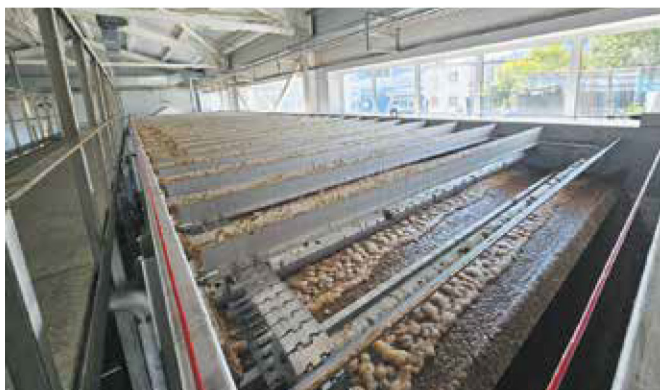
Рис. 2. Иловый флотатор
